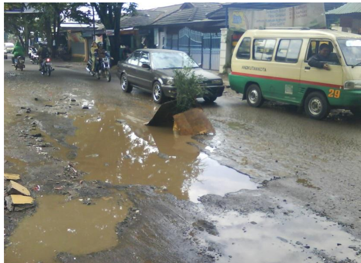
Gambar 2-2 Kondisi Ruas Jalan yang Rusak di Kota Bandung
