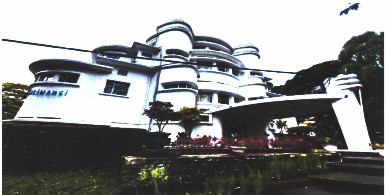
Gambar 03. Kondisi bangunan Villa Isola di sisi utara Sumber: Tim Pendaftaran Disbudpar Kota Bandung, 2025
