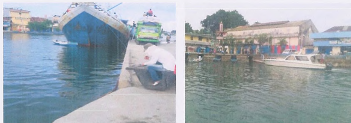
Gambar 3.14 Situasi Terminal Pelra
